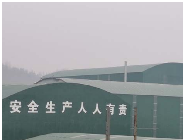
项目车间现状
