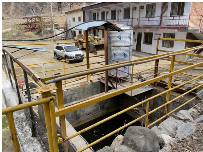
初期雨水收集池
