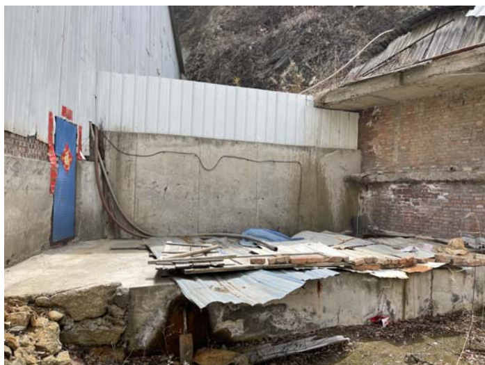
生产废水沉淀池
