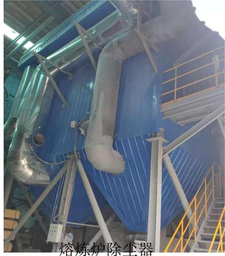
熔炼炉除尘器
