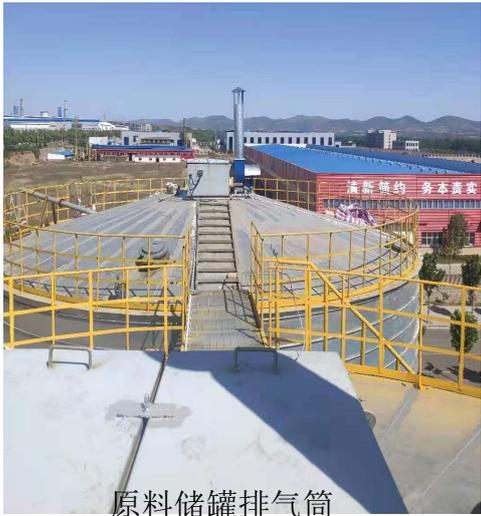
原料储罐排气筒
