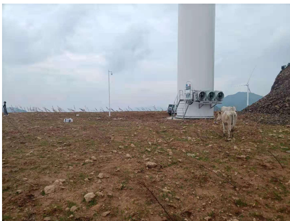
风机临时占地生态恢复
