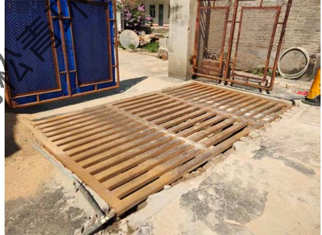
车辆冲洗装置、车辆冲洗沉淀池
