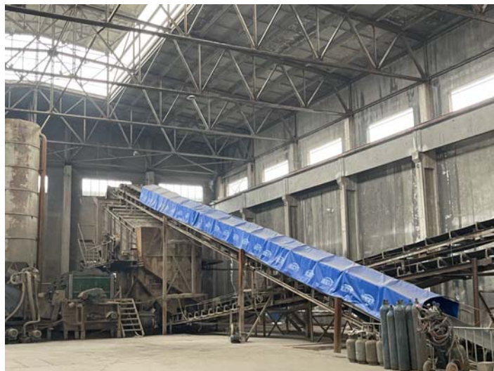
皮带廊道封闭
