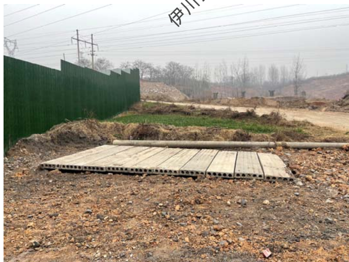
初期雨水收集池
