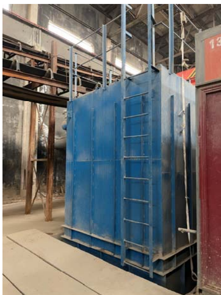
1#生产线袋式除尘器+15m 高排气筒
