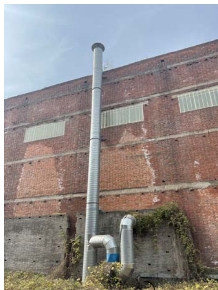
1#生产线袋式除尘器+15m 高排气筒
