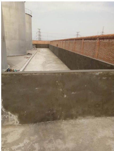
液蜡罐区围堰
