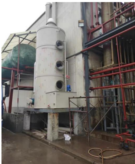
工艺废气处理设施(三级石墨降膜吸收+三级填料吸收制酸+二级填料吸收塔+25m 高排气筒)
