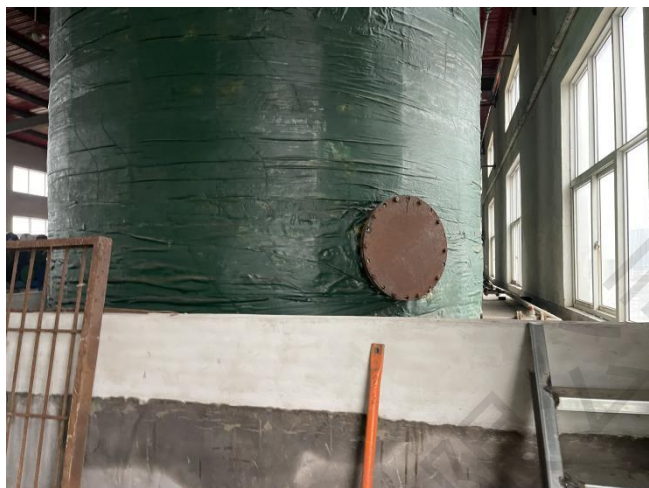
成品库储罐围堰
