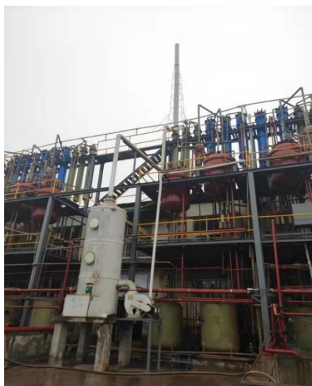
工艺废气处理设施(三级石墨降膜吸收+三级填料吸收制酸+二级填料吸收塔+25m 高排气筒)
