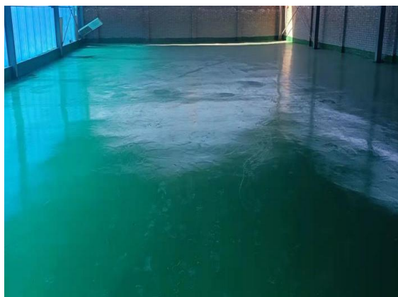
危废暂存间地面防渗
