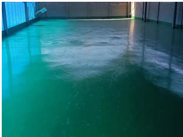
危废暂存间地面防渗
