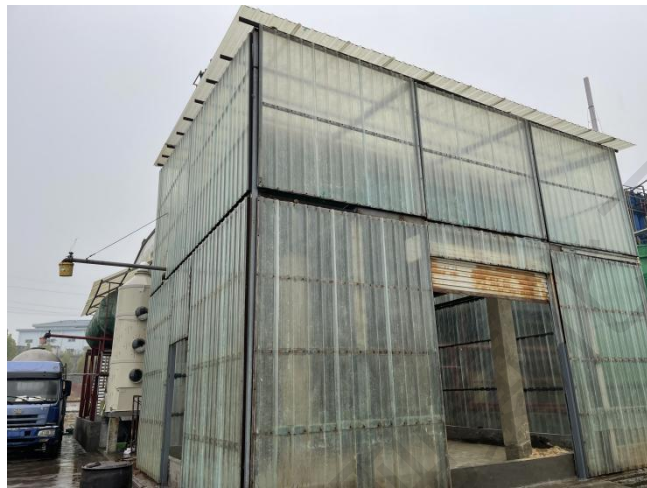
成品储罐封闭设围堰
