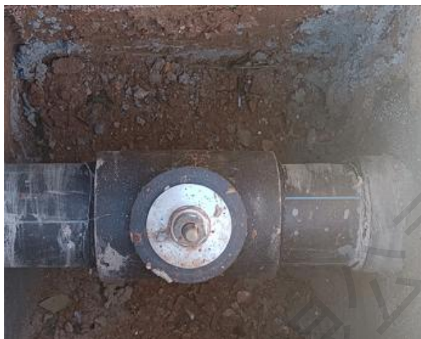
初期雨水收集池雨水闸阀
