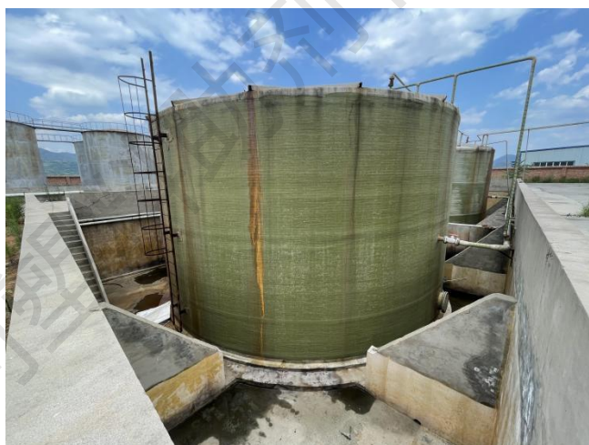
盐酸罐区围堰
