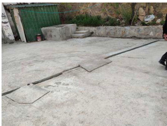
厂区地面硬化、设置雨水导流渠
