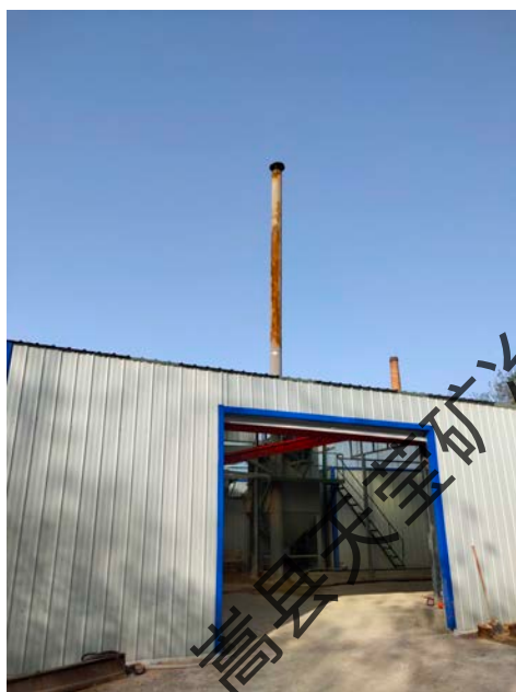
破碎筛分废气排气筒（2#排气筒）
