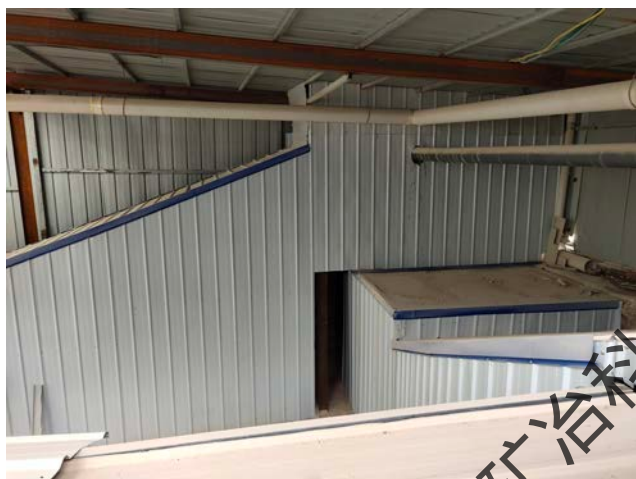
破碎筛分设备及输送带封闭
