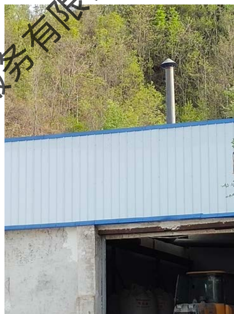
磨粉包装废气排气筒（2#排气筒）
