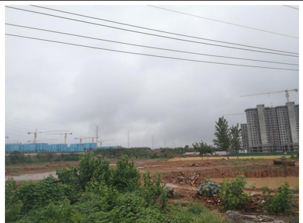
地块外空地及现状围墙
