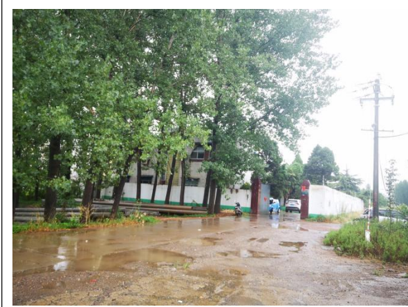
地块西侧 50m 变电站
