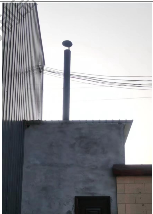
锅炉房排气筒
