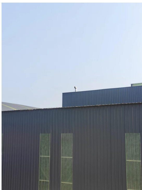
袋式除尘器排气筒
