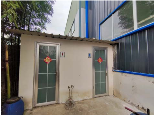
化粪池所在区域
