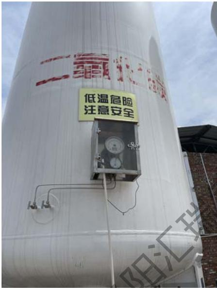
储罐液位、压力指示
