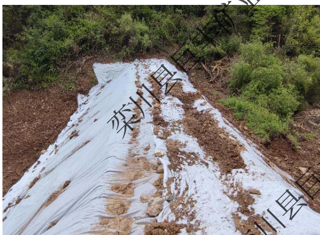
尾矿库 4#溢流井下游拦截坝
