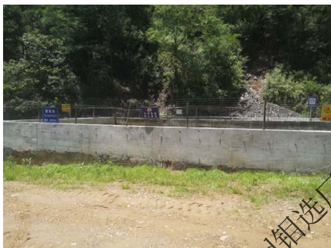
尾矿库澄清水池
