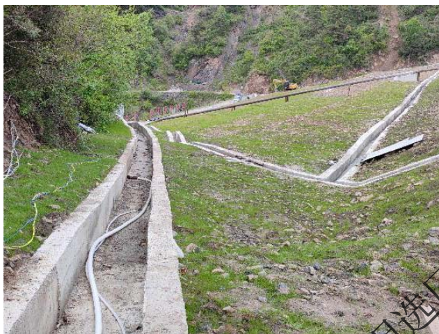
基础坝址右侧山谷截洪沟
