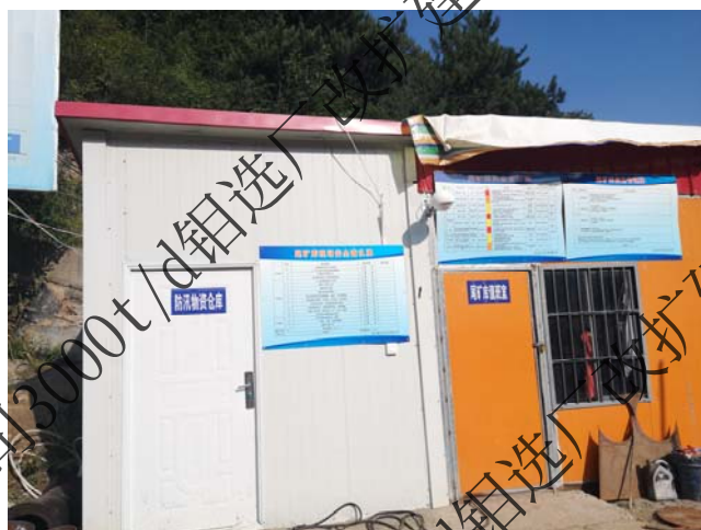
尾矿库值班室和防汛物资库
