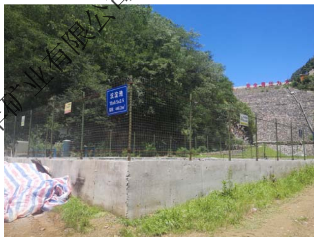
尾矿库沉淀池
