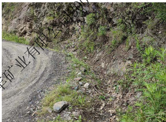
上坝道路沿山体一侧排洪沟
