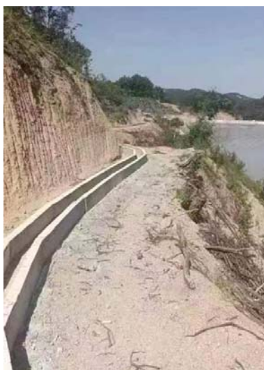
尾矿库临山侧已设置雨污分流排水渠
