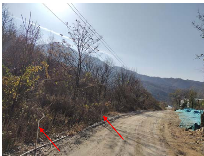
运输道路两侧安装喷淋洒水降尘喷头
