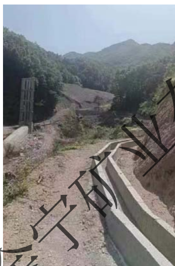
尾矿库临山侧已设置雨污分流排水渠
