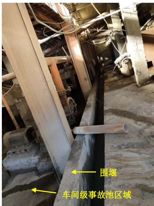
选厂设备下方设置围堰、事故池
