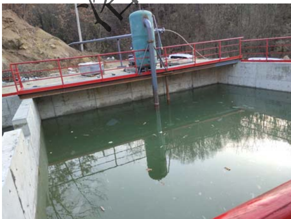
尾矿库回水池
