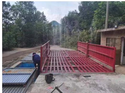
厂区出入口设置车辆冲洗设备及沉淀池
