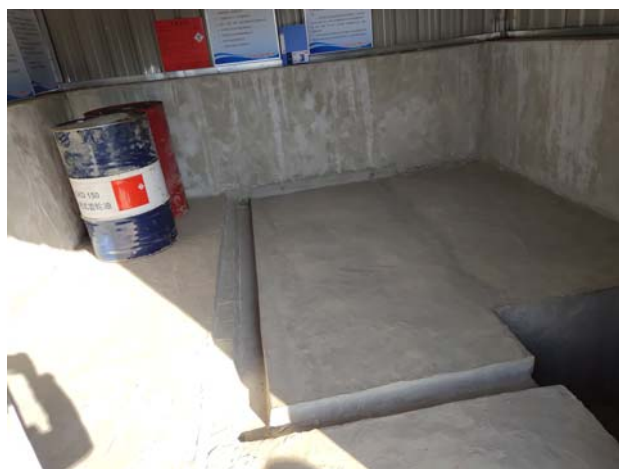
危废间内部：已采取地面防渗、张贴危废标签、设置管理制度、地面设置导流渠和废液泄露收集池措施
