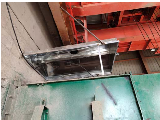
颚式破碎机上方设置集气罩
