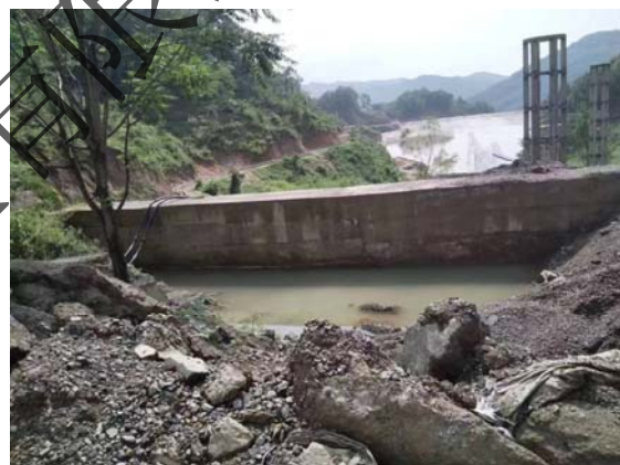
尾矿库库尾设置的雨污分流挡水坝
