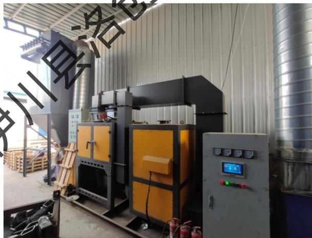
TA003 覆膜砂制芯、浇铸等产生的 VOCs 配套的催化燃烧装置及排气筒 DA002
