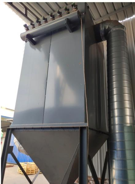
TA002 落砂、覆膜砂浇铸等产生的粉尘配套的除尘器
