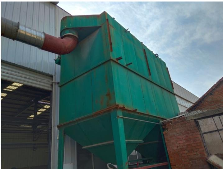
TA001 熔炼、水玻璃石英砂浇铸、混砂造型产生的颗粒物除尘器
