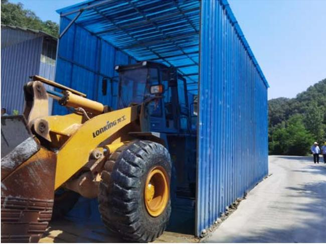
施工车辆冲洗装置
