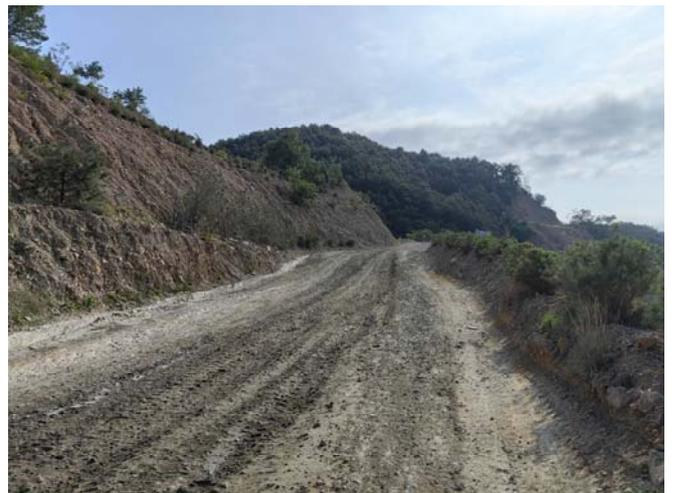
废石运输道路铺设石子、两侧绿化
