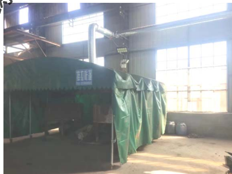
水玻璃石英砂混砂、造型和落砂区伸缩棚二次封闭措施
