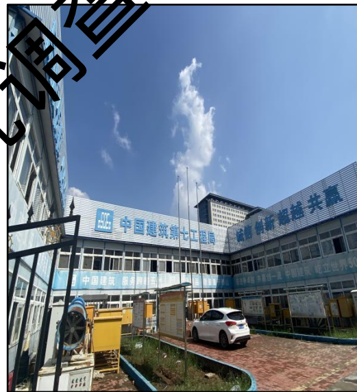
图 1-2 中国建筑第七工程局办公营地
