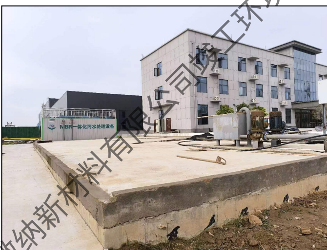
事故池和初期雨水收集池
