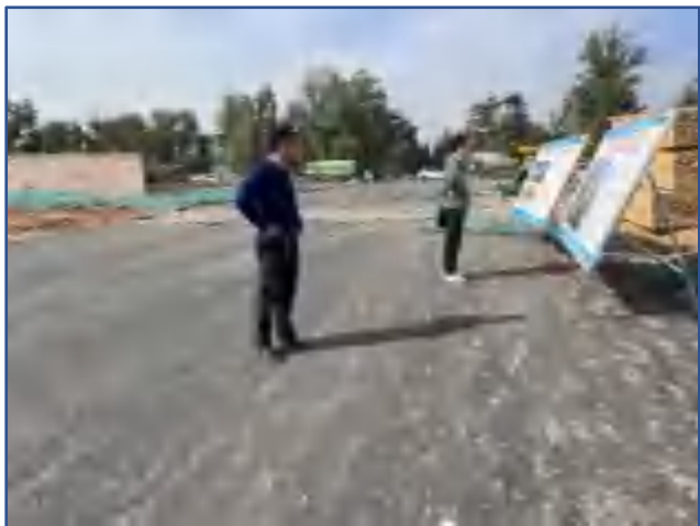
本项目现状图片
