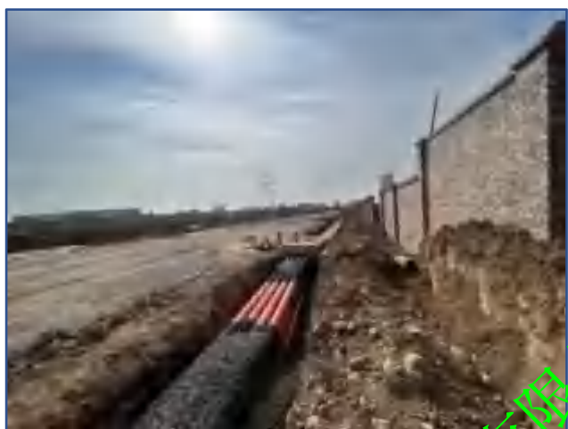
项目东侧在建启明路
