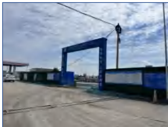
项目北侧在建北环路
