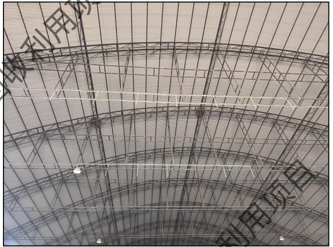
车间喷干雾抑尘装置
