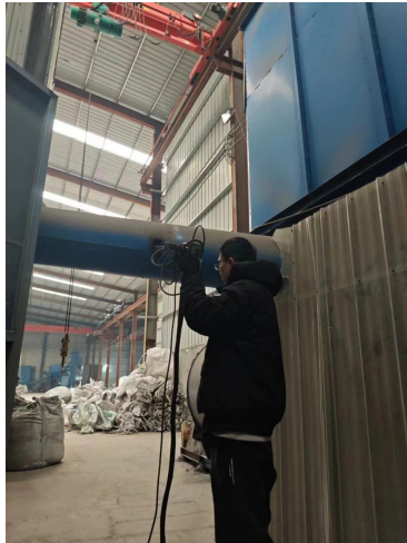
有组织废气现场检测照片
