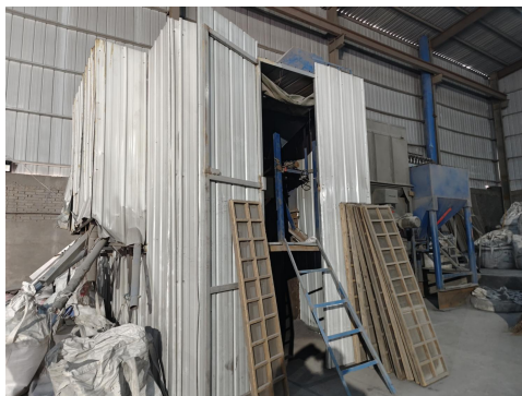
2#风洗机封闭措施
