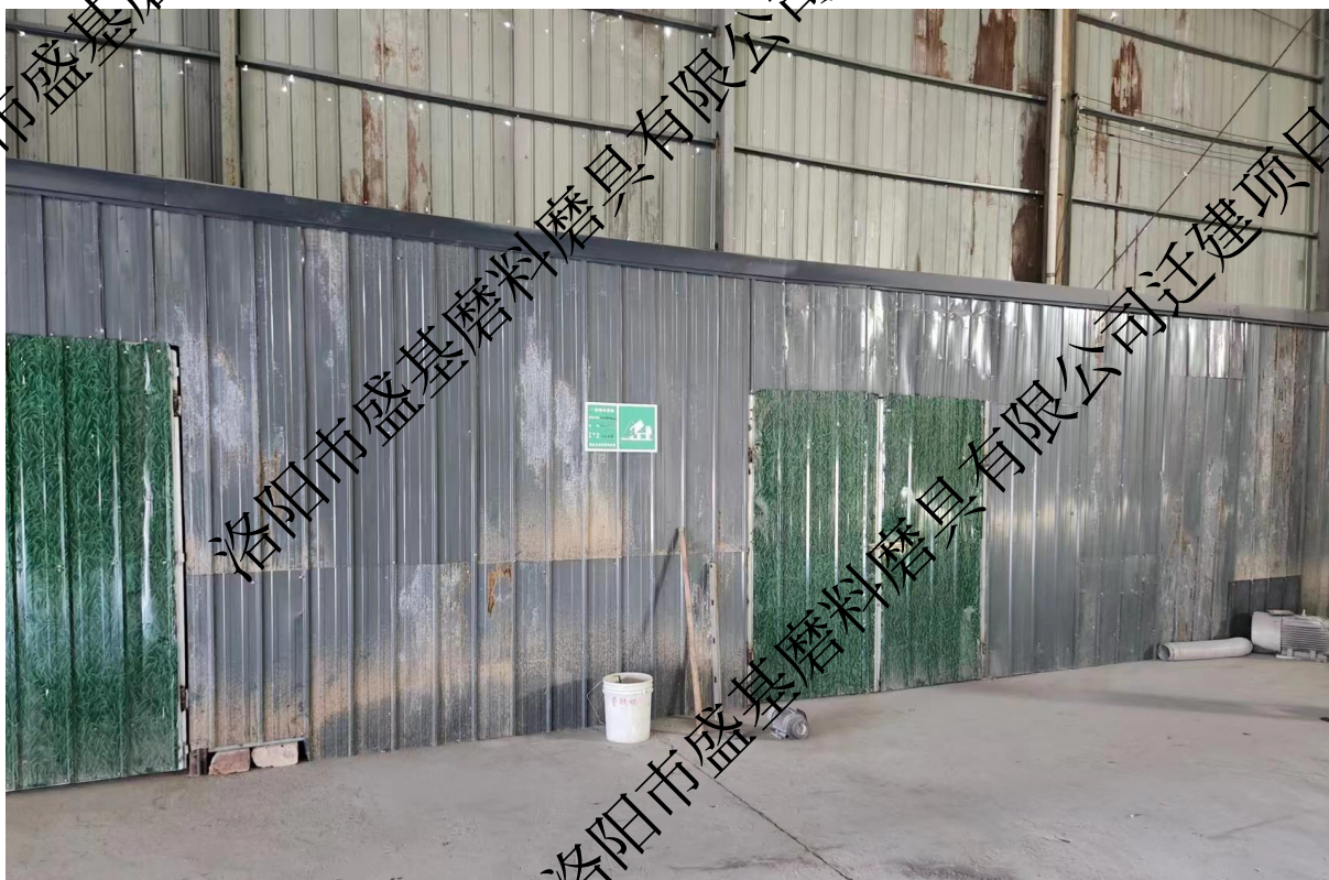
一般固废暂存间
