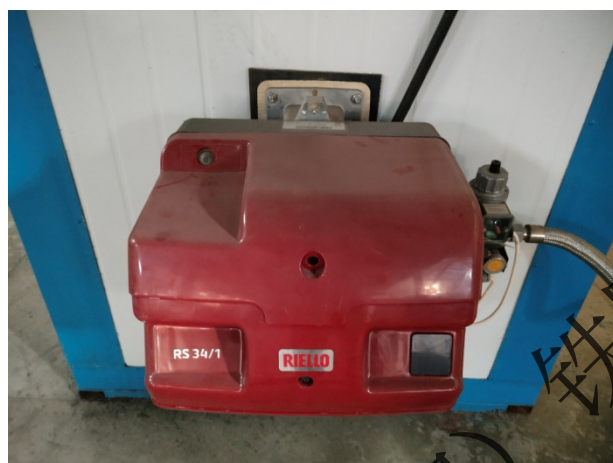
天然气炉窑采取低氮燃烧措施
