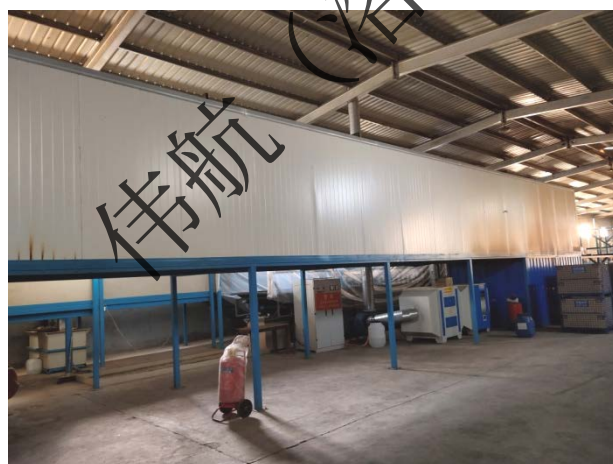
天然气炉窑窑体封闭
