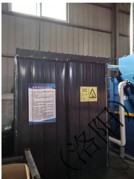
危废暂存间（外部）
