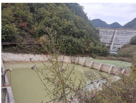
尾矿库下事故池
