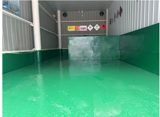
选厂危废暂存库
