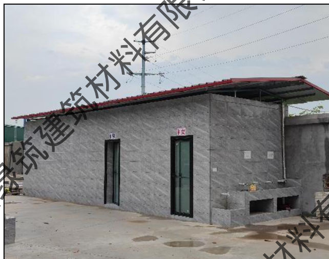
项目卫生间及化粪池
