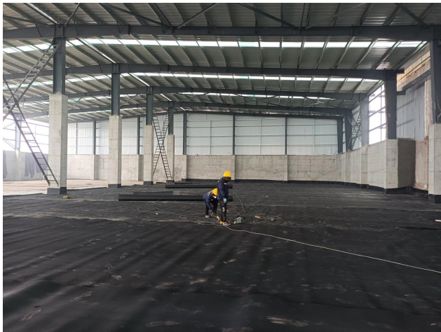
尾渣库地面防渗施工
