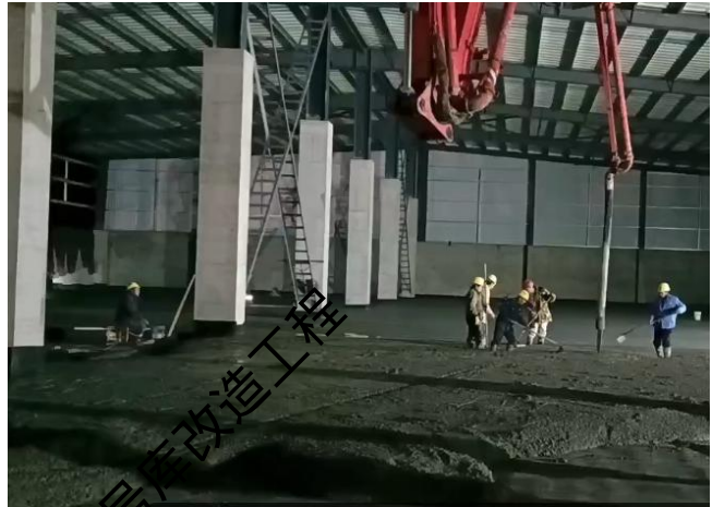
尾渣库地面防渗施工
