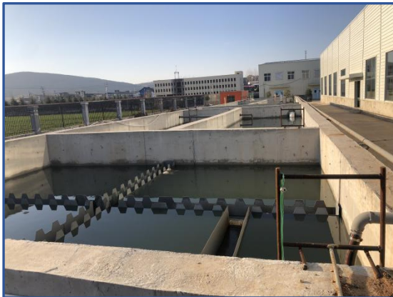
施工期污水处理站照片
