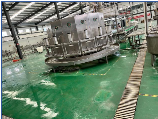
生产车间地面导流槽
