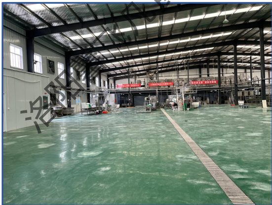
生产车间地面导流槽
