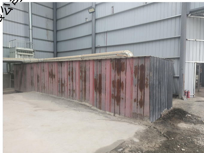
沥青拌合料输送带封闭
