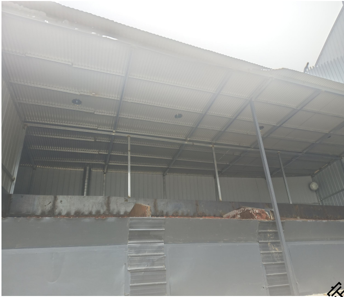
水稳拌合料下料口三面密闭
