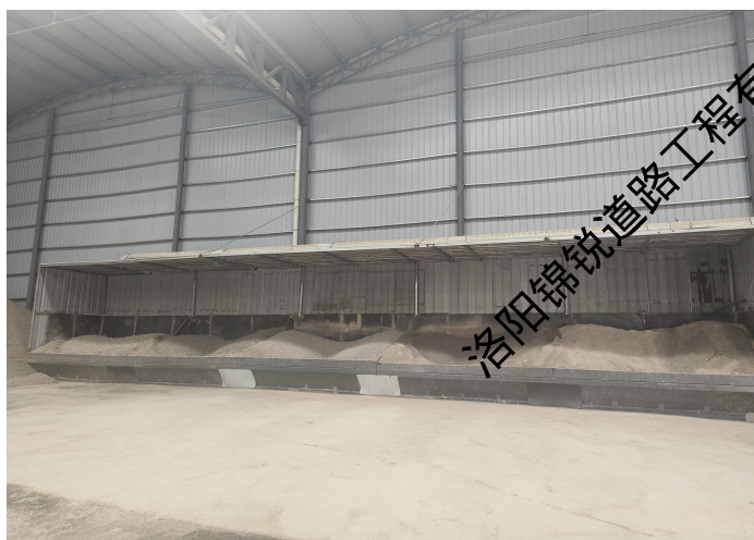
沥青拌合料下料口三面封闭
