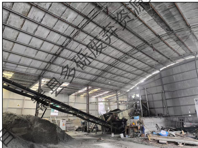
制砂车间现状
