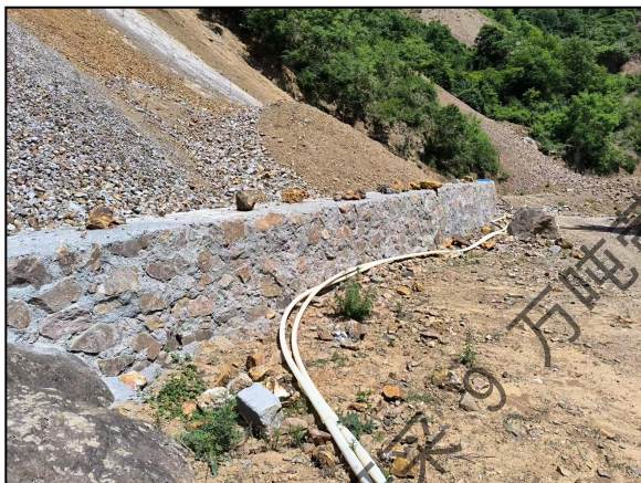
民采坑西南山体外侧挡渣墙
