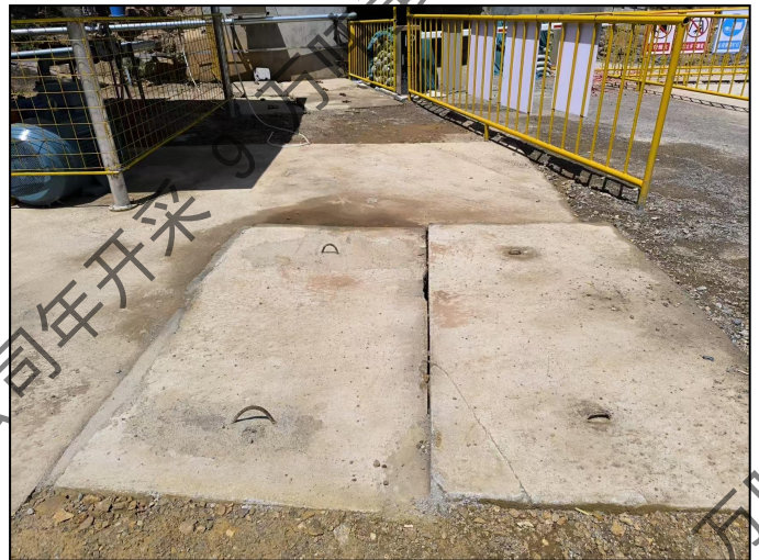
矿井涌水收集池
